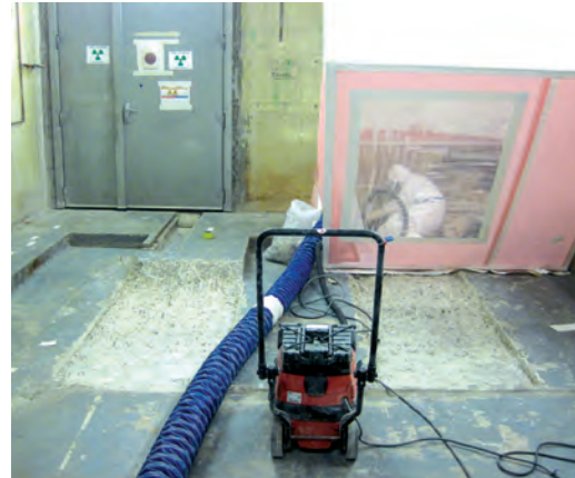
Travaux dans un hall bâtiment 53.
