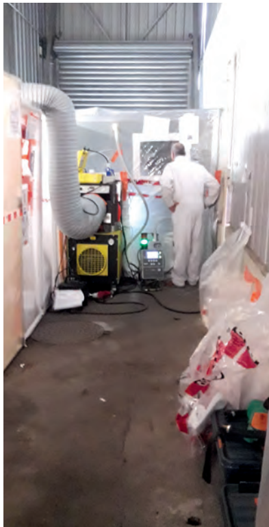
Dépose de bitume amianté dans le passage couvert entre les bâtiment 53 et bâtiment 58.
