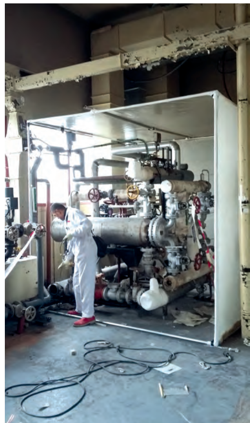
Dépose d'une sous station de chauffage bâtiment 53.
