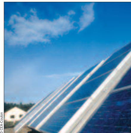
Panneaux solaires en silicium polycristallin au centre d'études de Cadarache.
